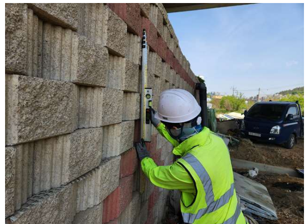
경사계를 이용한 경사도 측정
