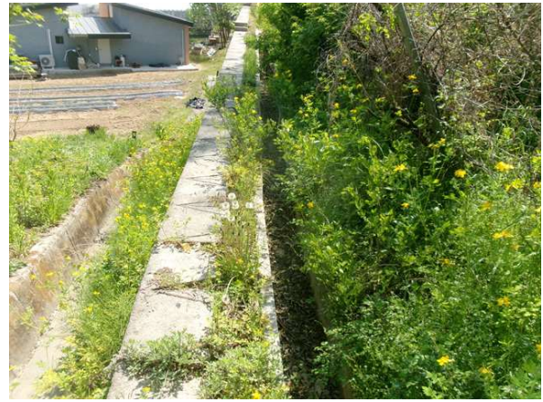
상부 배수로 전경
