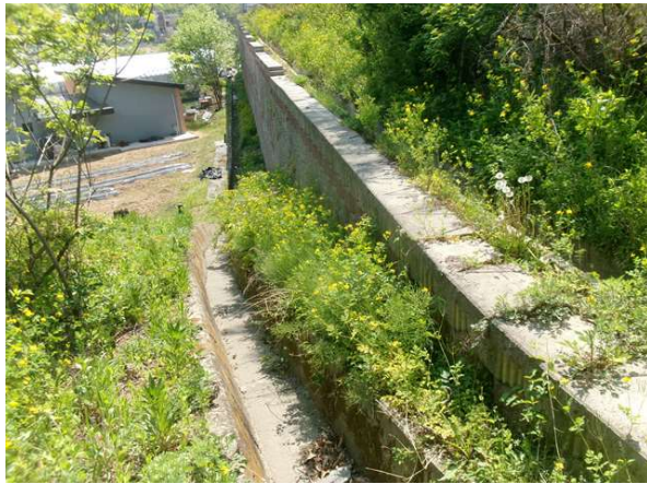
하부 배수로 전경
