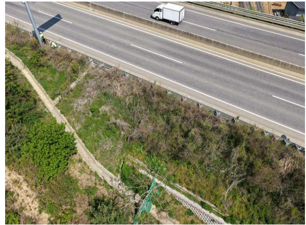
상부 성토부 전경
