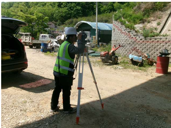
광파기를 이용한 측량 작업
